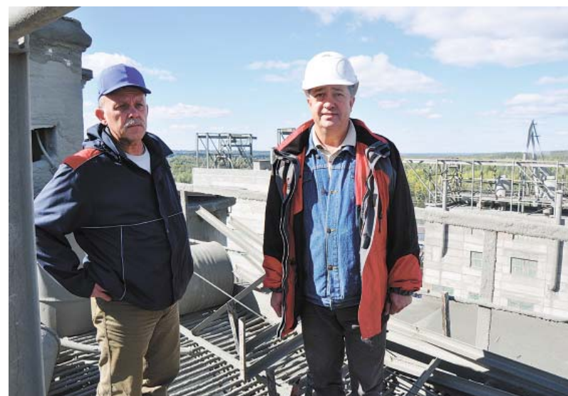
В 2013 году были проведены ремонтные работы по замене кровли на силосах.
