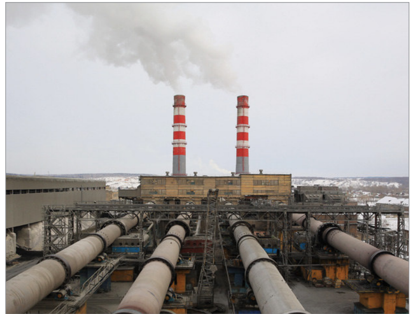
АО «Искитимцемент». Цех обжиг. Вращающиеся печи.
